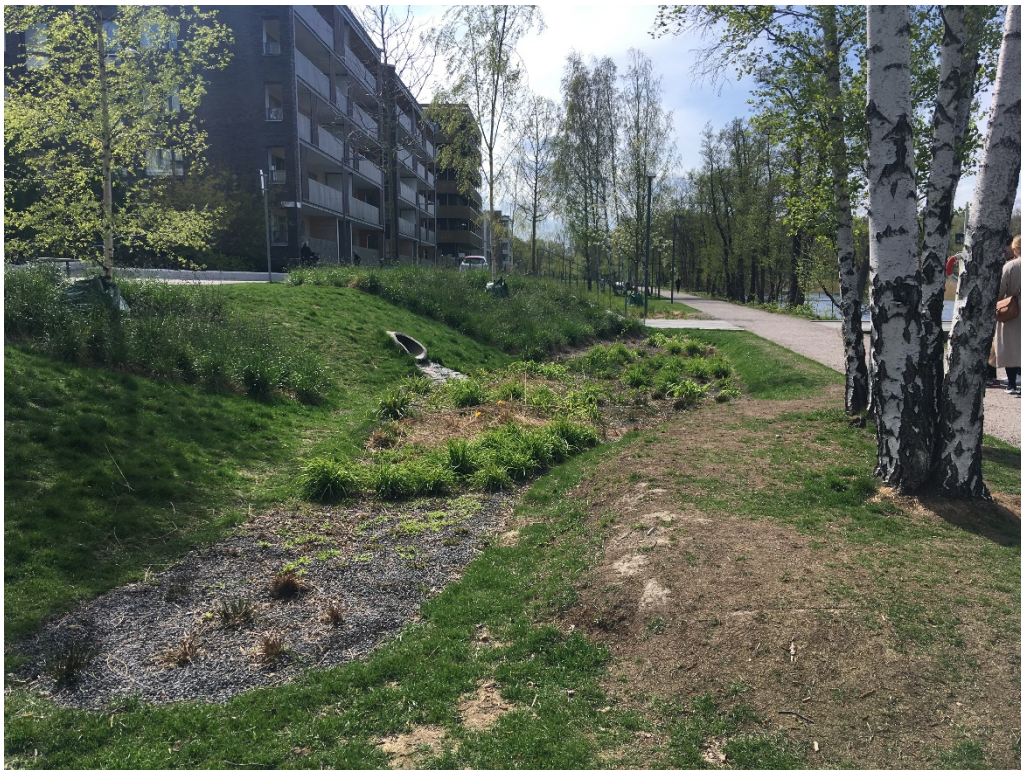
Illustration 12 Torrdamm, Norra Djurgårdsstaden
