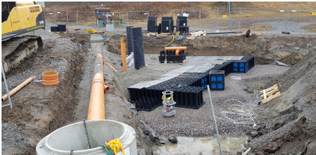
Illustration 10 Anläggande av dagvattenmagasin i Brotorp. Dagvattenmagasinet är till för fördröjning och består av dagvattenkassetter.
