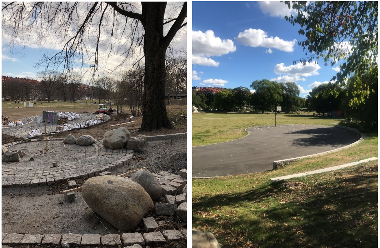
Illustration 11 Multifunktionell yta för skyfallshantering i Rålambshovsparken. Vänstra bilden visar skyfallsdammen vid anläggning.
